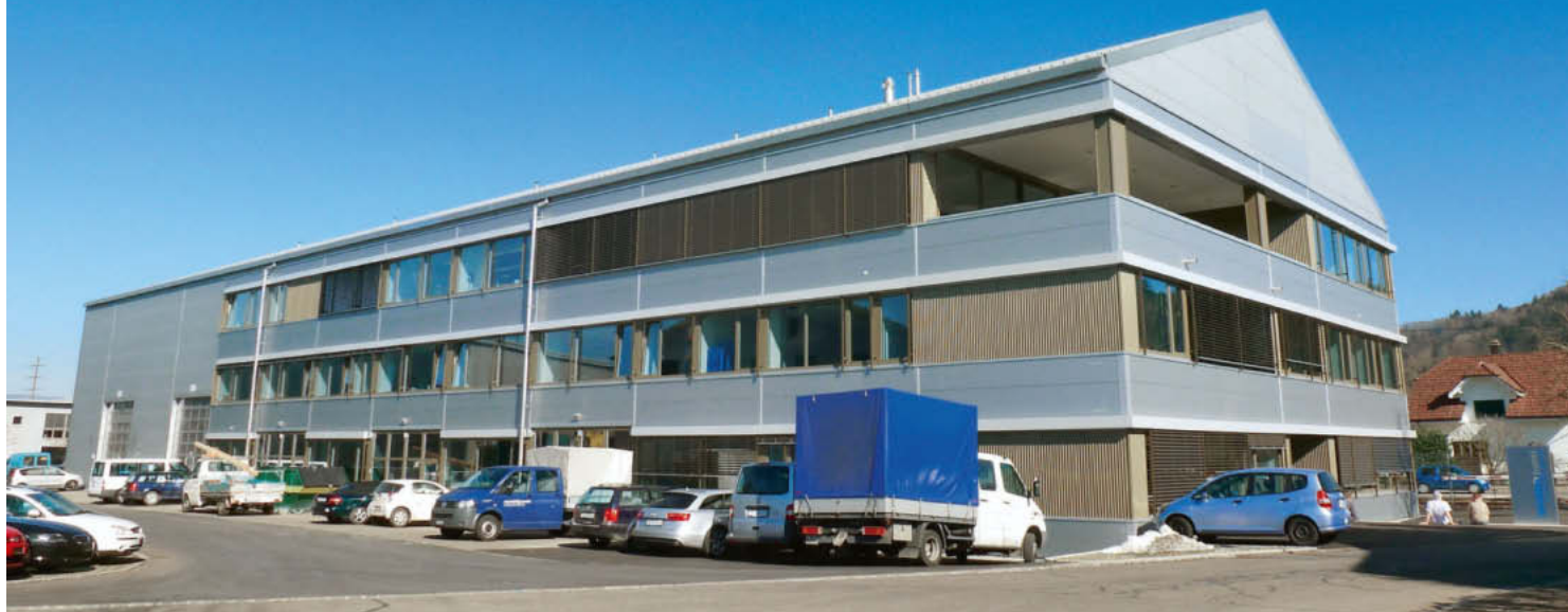
Das Betriebsgebäude der Stiftung Wendepunkt in Muhen AG: Die Komplexität des Unternehmens war ohne neue Software administrativ kaum mehr zu bewältigen.
