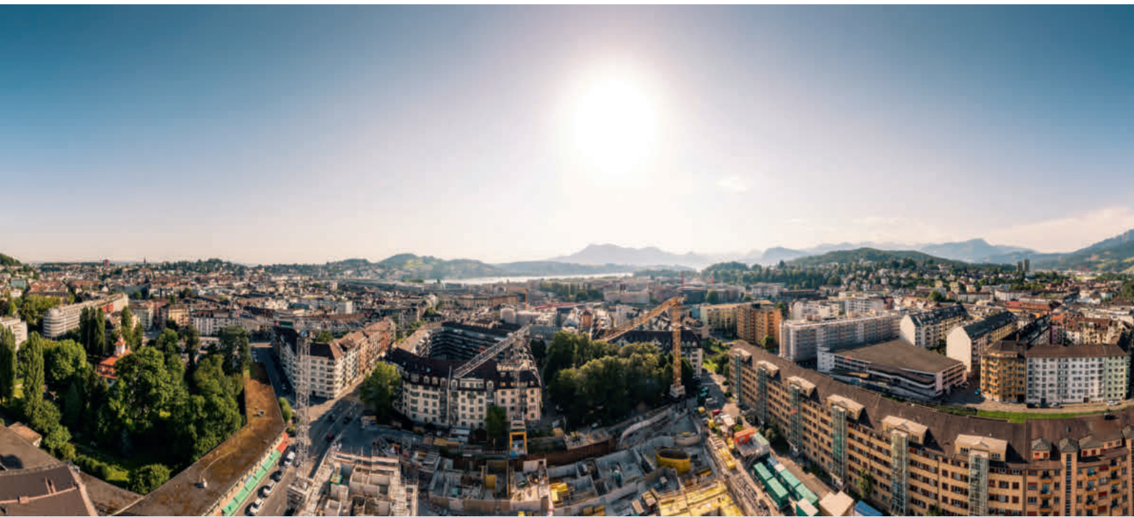
Das Neustadtquartier in Luzern (mit dem «Bleichergärtli» in der Bildmitte und der Baustelle für die neue Siedlung der Allgemeinen Baugenossenschaft Luzern): Mit der Urbanisierung ging eine gewisse Anonymisierung einher.
