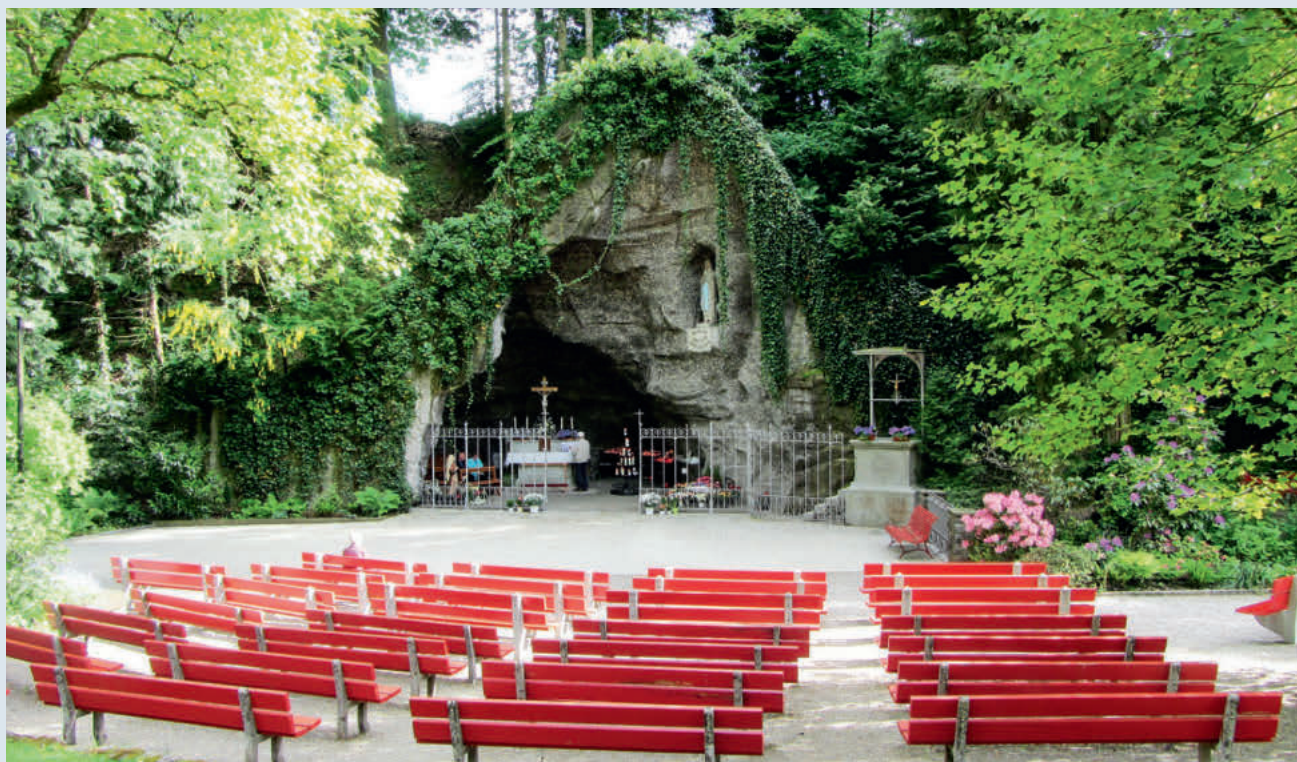
Lourdes-Grotte in Leuggern AG: Kopie aus Spritzbeton.
